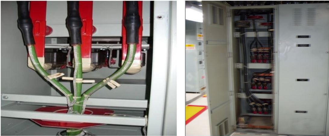
그림 5-4. 고압 및 저압 스위치기어 패널 후면
