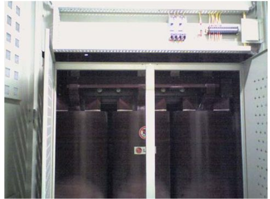
그림 5-6. 건식변압기 패널문 개방후 열화상측정 사진
