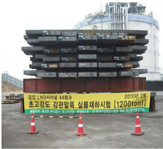
(c) LNG 탱크 신설공사
