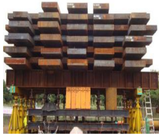
(b) SILO 신설공사
