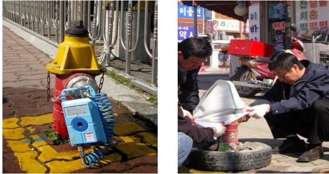
그림 4.2 소화전 수압계 설치전경
