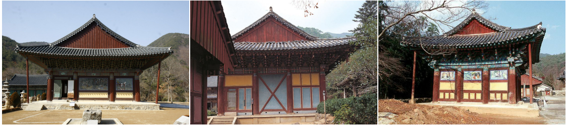
그림 132. 운문사 대응보전 우측면 그림 133. 화엄사 대응전 우측면 그림 134. 금산사대장전 좌측면
