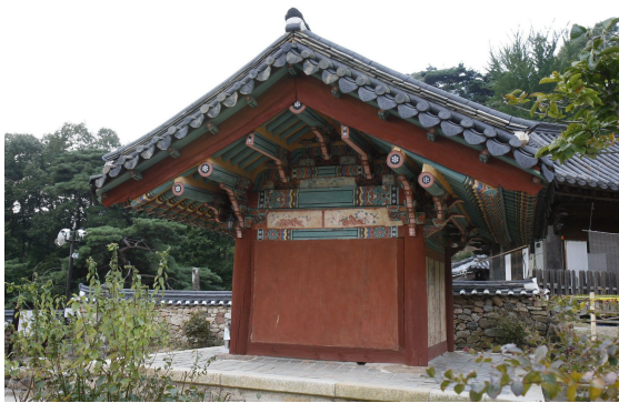
그림 119. 관룡사약사전 우측면 전경
