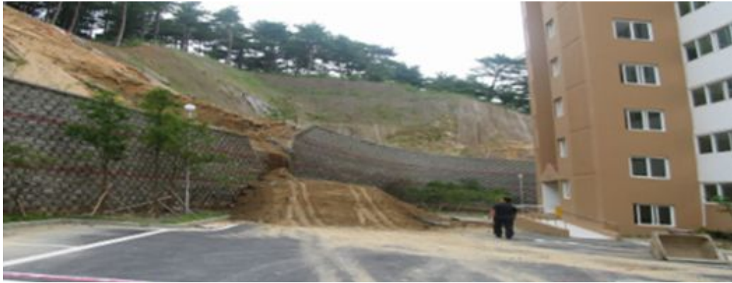
그림 2.13 B현장 (강원도) 벽체상부 붕괴현장 : 강우시 계곡지표수 유입
