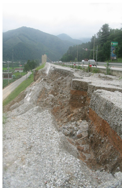
그림 2.15 D현장 (강원도) 벽체전도현장 : 지표수유입에 의한 세굴 및 전도
