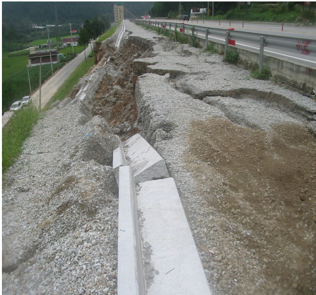
그림 2.15 D현장 (강원도) 벽체전도현장 : 지표수유입에 의한 세굴 및 전도
