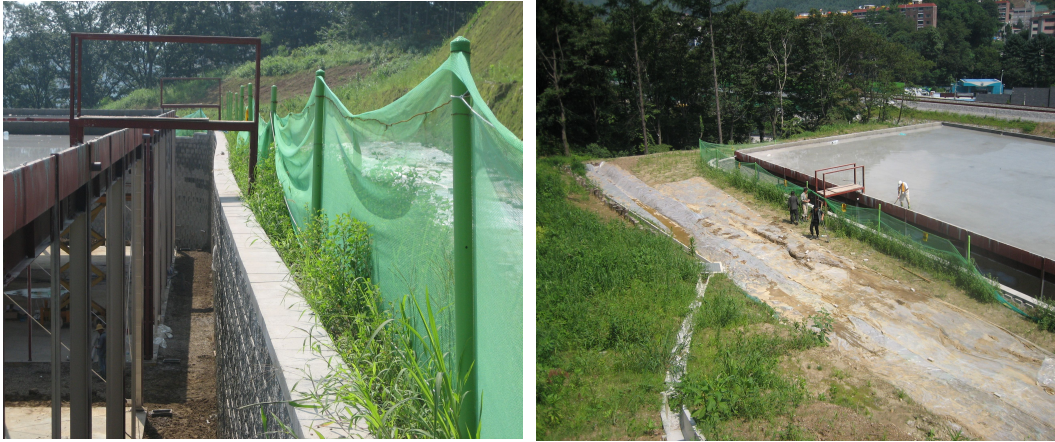
그림 2.17 F현장(경기도) : 계곡수 유입에 의한 벽체변위발생
