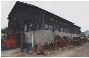
구 양천수리조합 배수펌프장 전경 출처 : 구 양천수리조합 기록조사보고서
