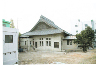
목포중앙교회 좌측면 출처 : 목포중앙교회 기록화조사보고서
