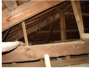
곡성삼기우체국 지붕내부현황 출처 : 본인촬영 2009.
