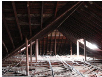
순천매산관 지붕내부현황 출처 : 본인촬영 2007.
