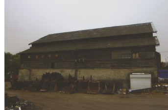
구 양천수리조합 배수펌프장 동측면 출처 : 구 양천수리조합 기록조사보고서
