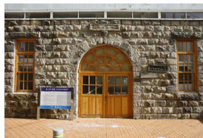
그림 76. 목포 舊 청년회관정면 출입구
