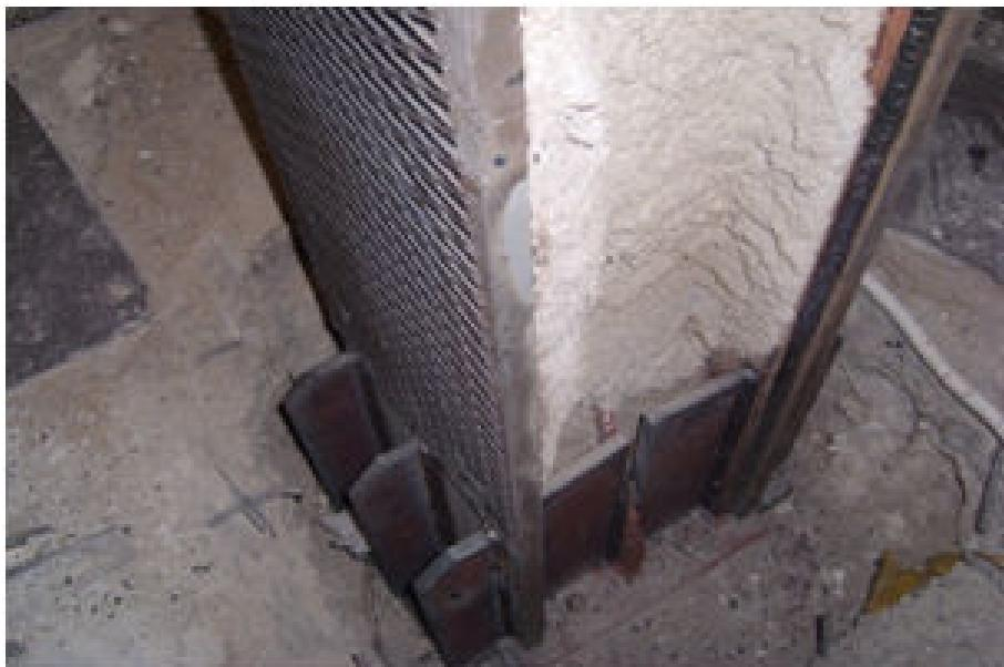
[사진 9] 기존 기등의 플랜지 및 리브보강과 마감용 라스 전경
