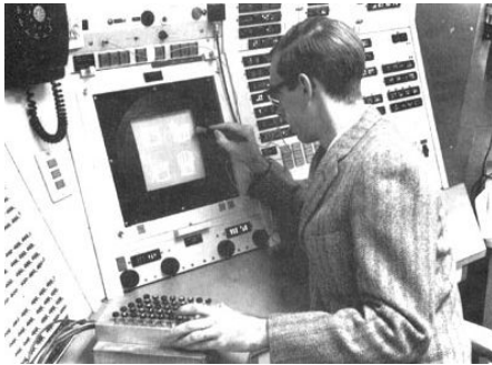
[그림 3] 이반 서덜랜드의 스케치패드 : 컴퓨터 스크린 위에서 라이트펜으로 그리고 스위치패널로 명령을 내려 추가적으로 그 경로를 볼 수 있다.
