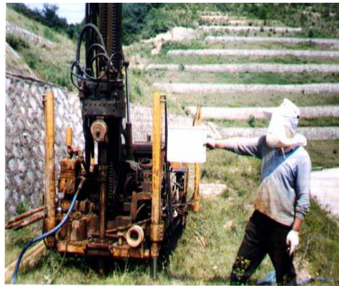
그림 4.2 토사사면 시추조사 전경
