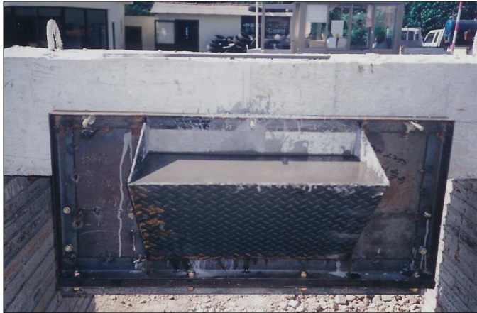
사진 4.2 중력식 Steel Plate Jack-up공법의 Mock-up Test 장면
