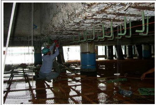
단면증설용 케미컬앵커 설치
