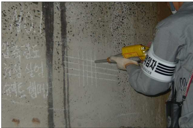
사진 3.5 콘크리트강도 측정 현황
