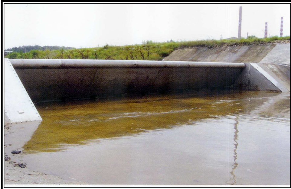
그림 3.7 장구 2취입보 가동보설치 전경
