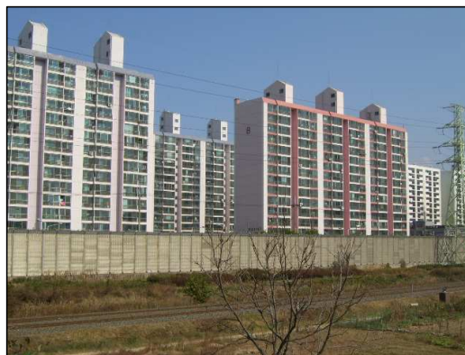
[그림 3-9] 수직적 철도교통소음 측정지역 현황
