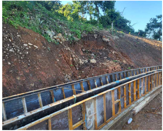
(b) 시공전 대상지
