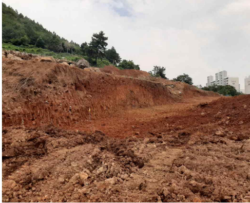
(a) 시공전 대상지
