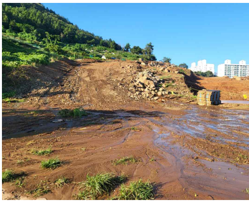
(c) 시공전 대상지
