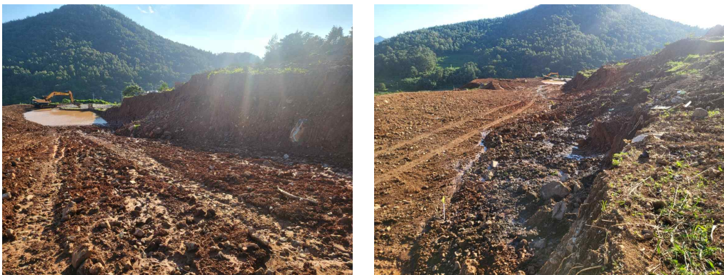
그림 4.1 옹벽 시공전 지반상태
