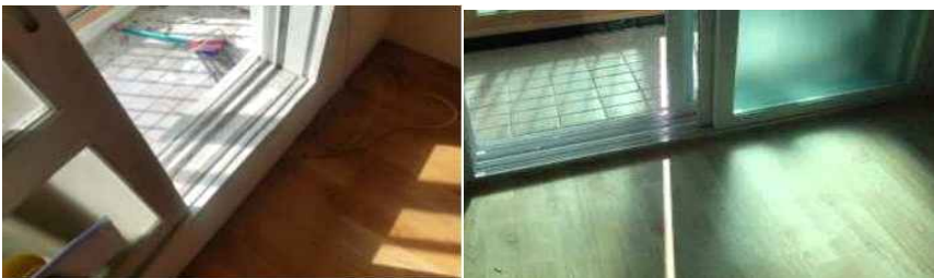
<베란다 리모델링 전·후>
