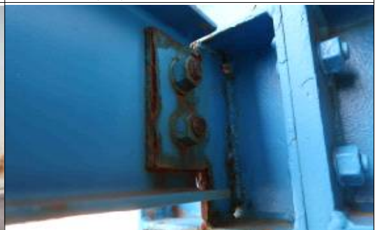
볼트접합부 도장박락 및 녹 발생
