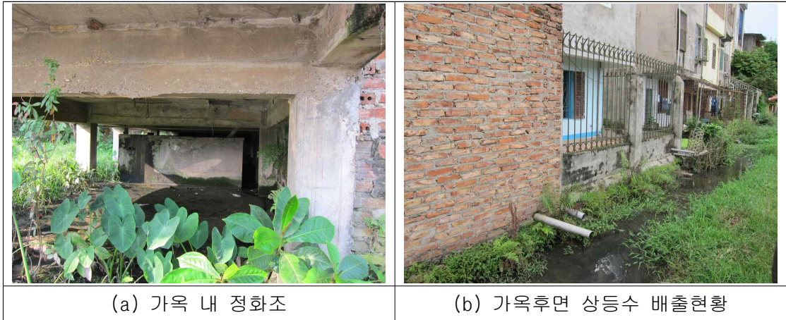
그림 4.5 Viet Tri 정화조 및 후면하수배제 현황
