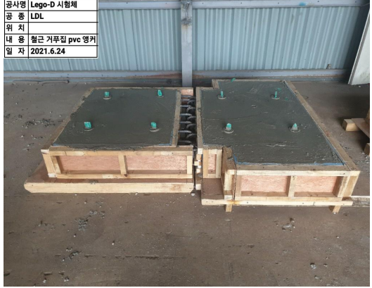
(d) 콘크리트 타설
