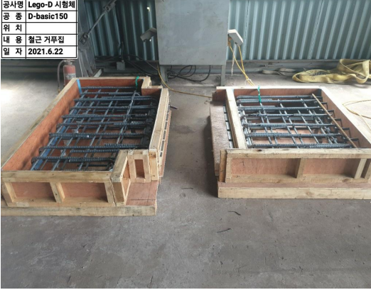
(c) 거푸집 내 조립 철근 배치
