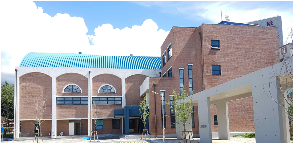
그림 4-1 사례 건축물 전경 사진
