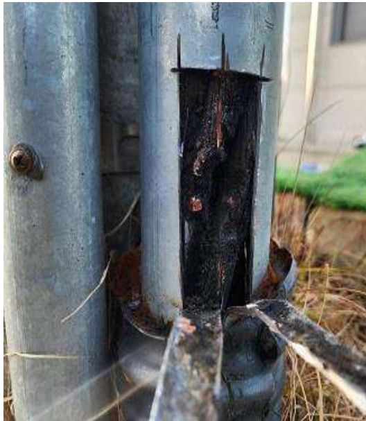
그림 7. 파이프 속의 누전으로 인한 전선 끊김 현상
