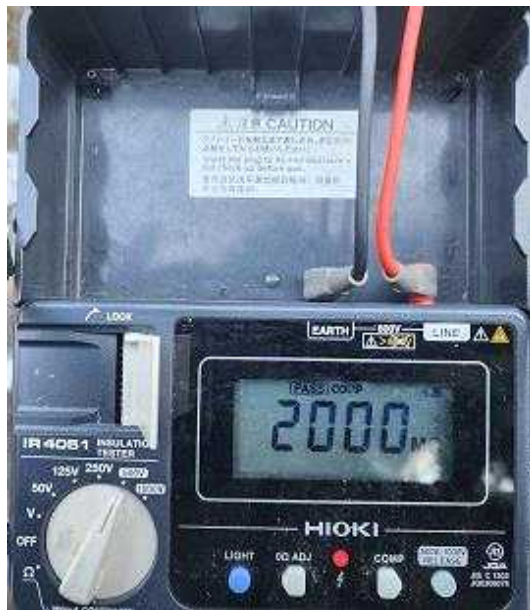
그림 4. 메거를 이용한 절연저항 측정
