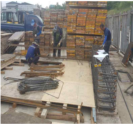
(a) 철근 조립
