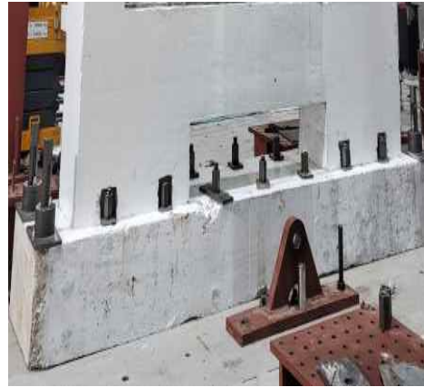
(d) 강재 락볼트 설치
