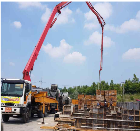
(c) 콘크리트 타설 및 양생
