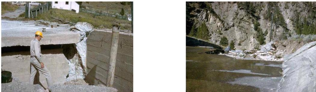
그림 2.5 Hebegen댐 피해사례 - 제방 침하 및 누수 전경
