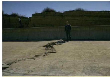
그림 2.2 Lower San Fernando 댐 피해사례 - 침하 및 횡방향 균열발생 전경
