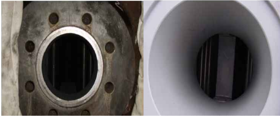
그림 21. F 모델과 CE-80 모델의 증기발생기 Hand-Hole 이미지
