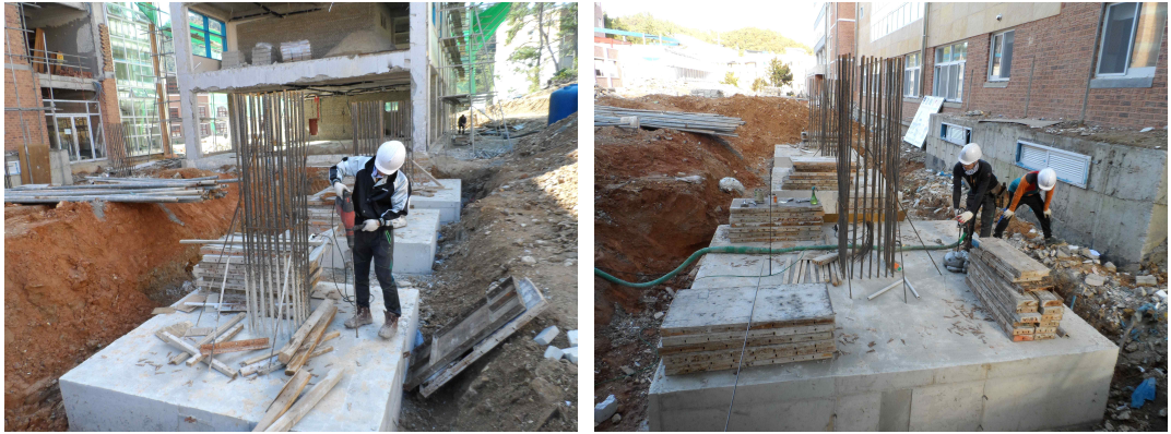
그림 4.23 독립기초의 지반보강 시공
