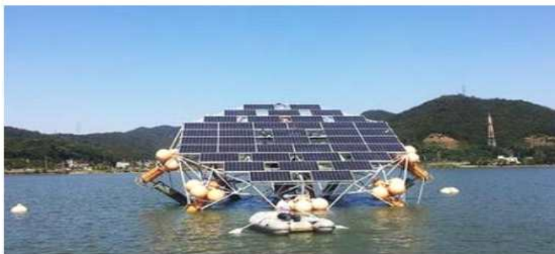
그림 2.4 수상 태양광발전(한국농어촌공사, 10kW)
