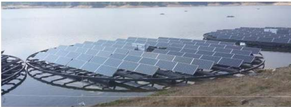
그림 2.5 수상 태양광발전(K-water, 100kW, 추적식)
