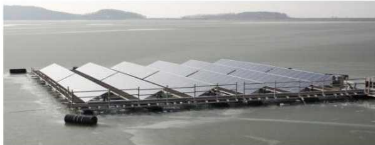
그림 2.3 수상 태양광발전(한국농어촌공사, 30kW)
