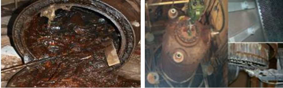
그림 1. 처분부적합 폐기물의 발생모습 - 제염해체 슬러지(L), 제염 후 2차 폐기물(R)
