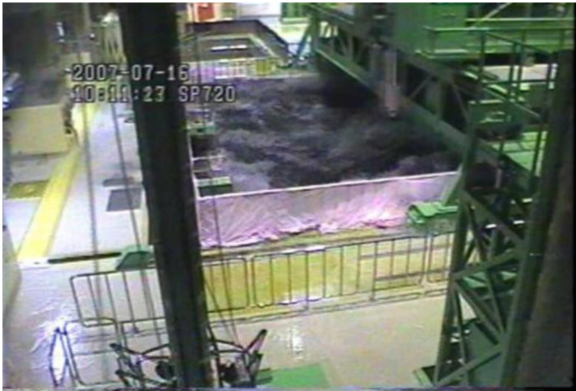
<그림 9> 가시와자키 가리와 6호기 사용후 연료저장조 물 유동 모습
