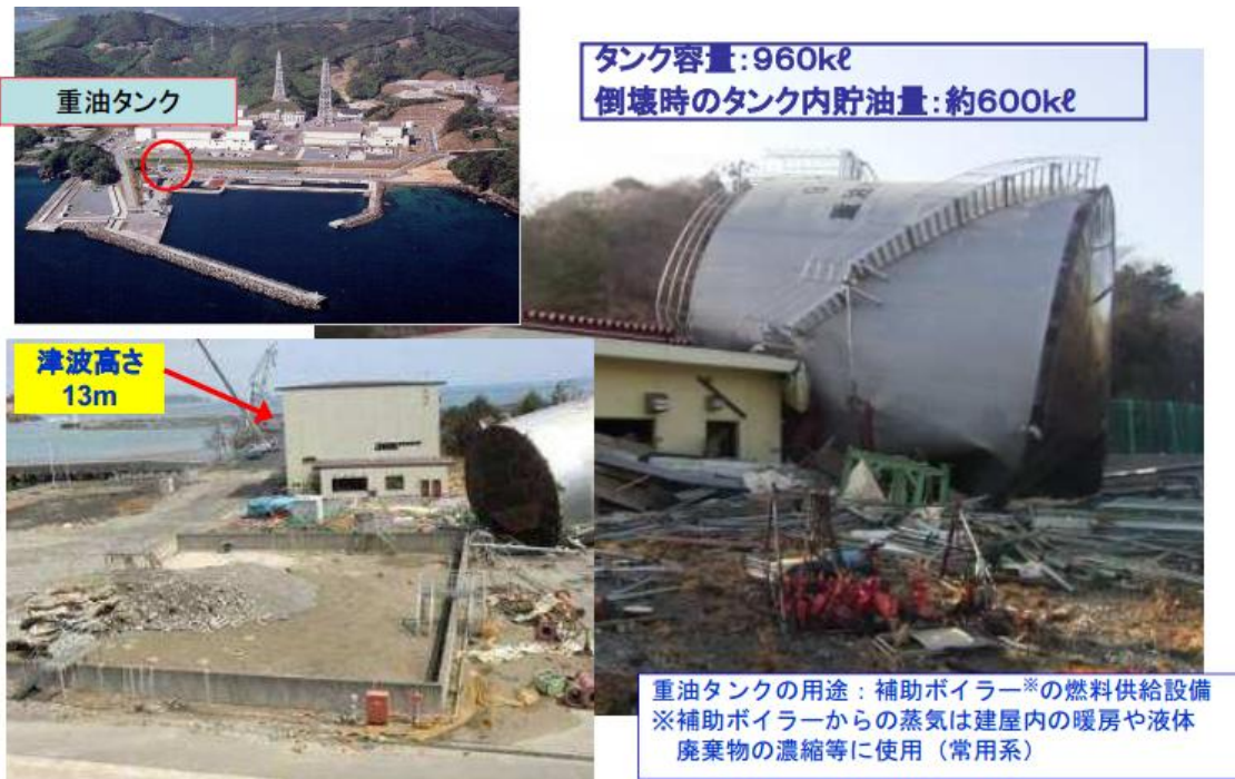
<그림 10> 오나가와 1호기 연료탱크 전도 및 유출
