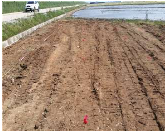
(b) 현장부지 정리 후 말뚝 위치 표시
