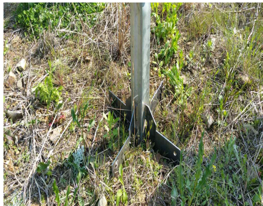
(b) Wing Pile 연결 후 압입
