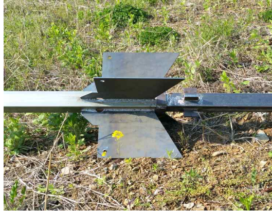
(b) Wing Pile과 하부기초 연결 모습
