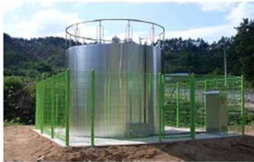
‘급수펌프 일체형 물탱크’의 현장설치 사진.
