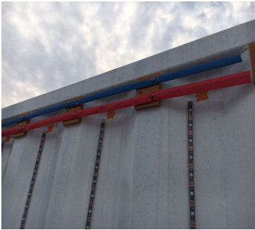
7. 구리바를 GND선에는 파란색으로 5V 전압선에는 빨간색으로 고무 커버를 씌우고 부착한다.
