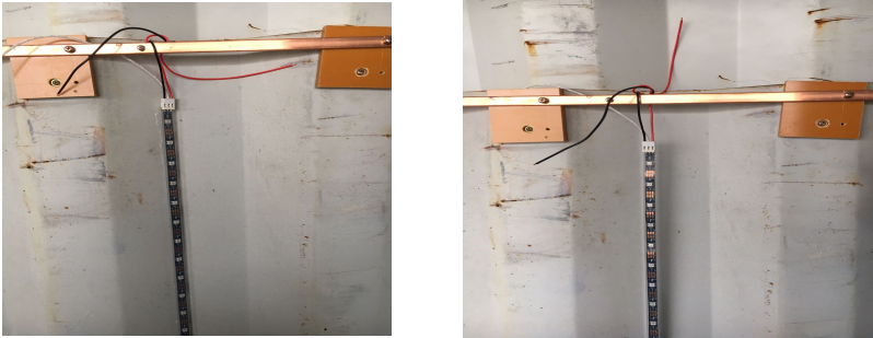
7. 이물감을 없앤 컨테이너 전면에 제작한 LED Strip을 부착한다.
