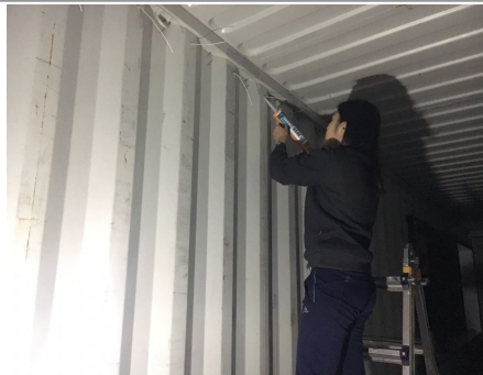
13. 컨테이너에 구멍을 뚫고 외부에 있던 선을 내부로 뚫린 구멍을 통해 보낸 뒤 파워 선을 연결한다.
