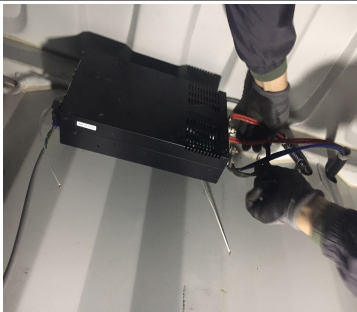
13. 컨테이너에 구멍을 뚫고 외부에 있던 선을 내부로 뚫린 구멍을 통해 보낸 뒤 파워 선을 연결한다.
