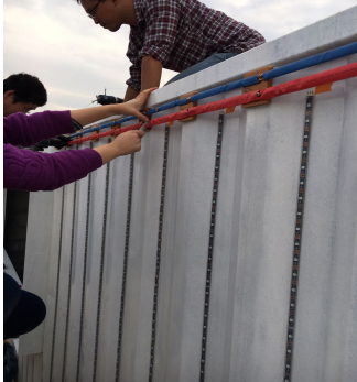
7. 구리바를 GND선에는 파란색으로 5V 전압선에는 빨간색으로 고무 커버를 씌우고 부착한다.
