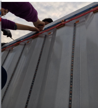
7. 구리바를 GND선에는 파란색으로 5V 전압선에는 빨간색으로 고무 커버를 씌우고 부착한다.
