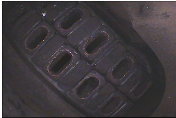
그림 4-14 월성 3호기 발전기 고정자 Clip-To-Strand 상태
