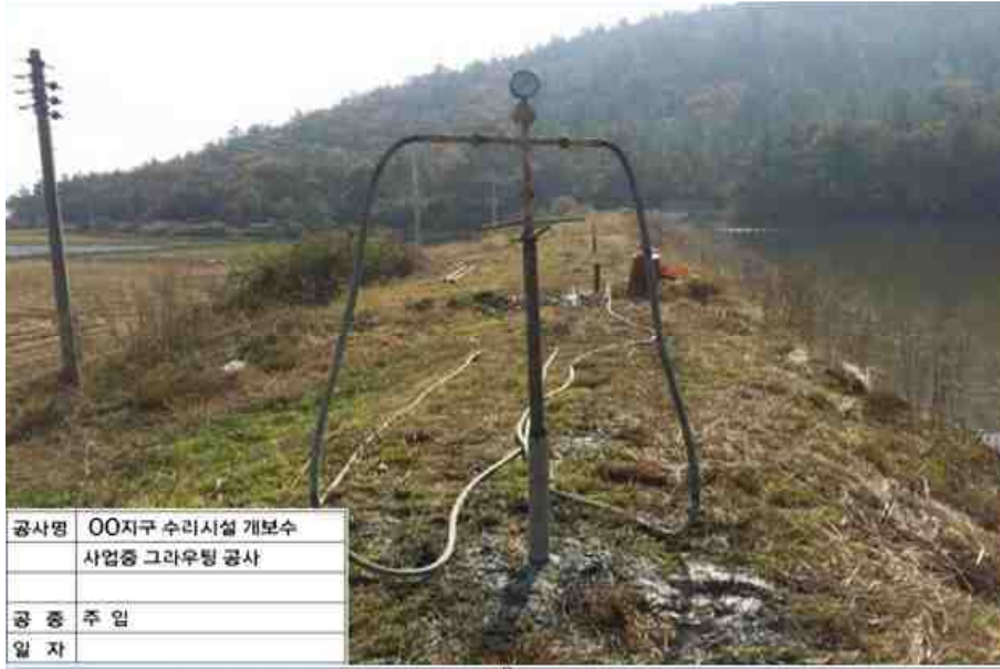
(c) 2역 1공정을 이용한 주입 모습
