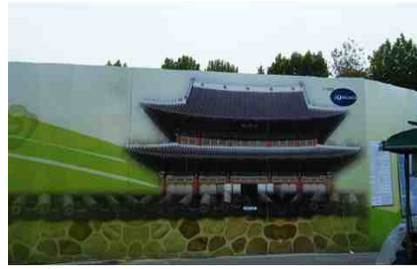
[그림 2-6] 종로 창덕궁 공사 가림벽
