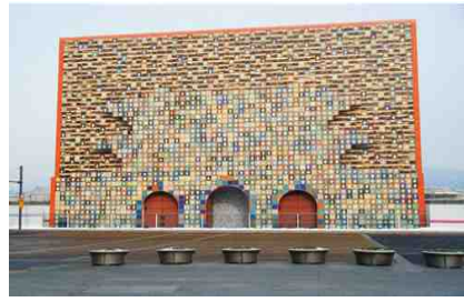
[그림 2-8] 광화문 복원 공사 가림막
