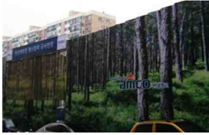
[그림 2-7] 현대백화점 램프증축 공사 가림막
