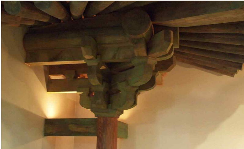
그림 10. 안압지 공포부재 복원 모형 (경주국립박물관 안압지관 내 안압지와 통일신라의 궁궐건축)
